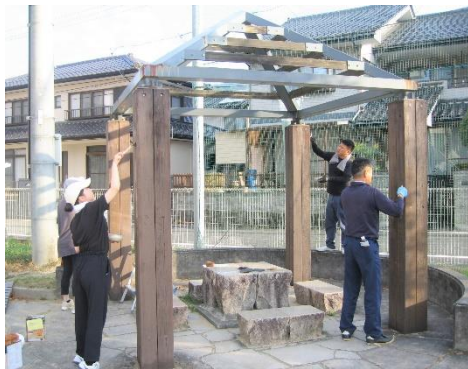
オイルステン塗り
