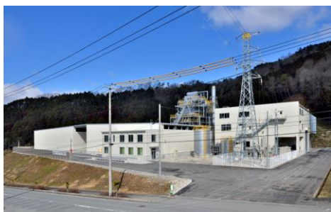
真庭バイオマス発電所 (出力10,000kW)
