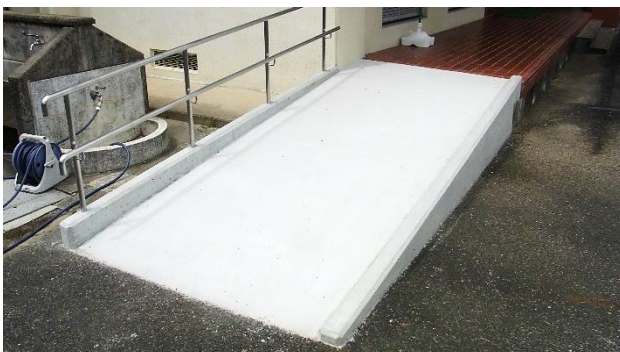
体育館への段差を解消するスロープ
