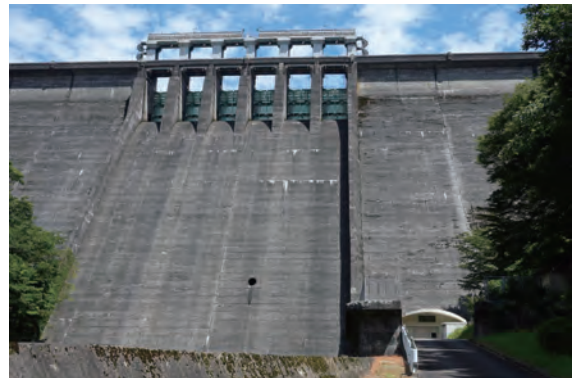
湯原えん堤発電所（右下の建物）
