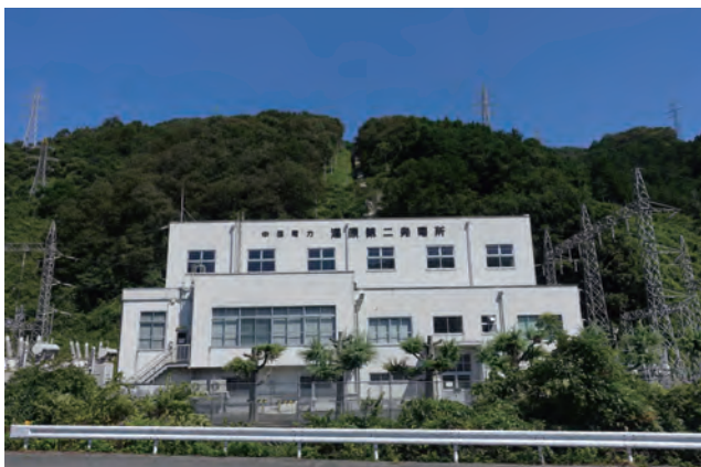
湯原第二発電所（久世・草加部）
