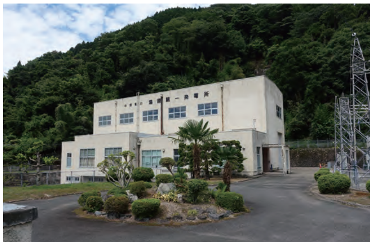
湯原第一発電所（湯原・豊栄）
