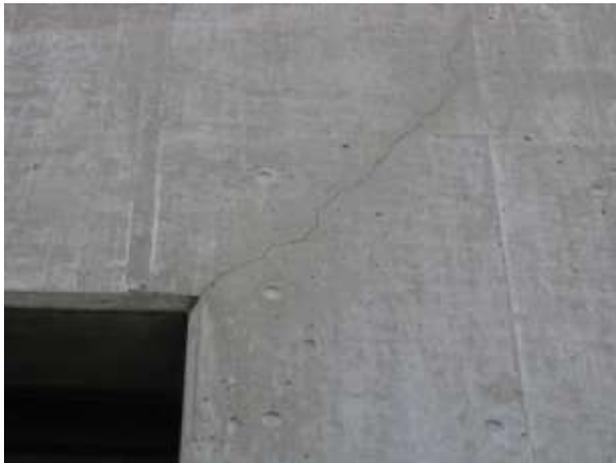
図 コンクリートのひび割れ
