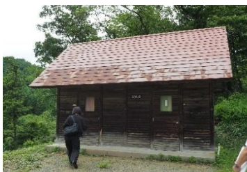
写真 建物外観
