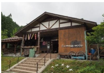
写真 建物外観
