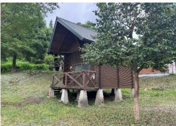
写真 建物外観
