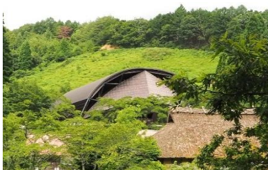
写真 建物外観
