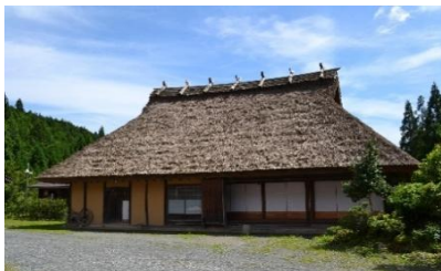
写真 建物外観
