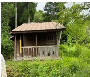
写真 建物外観
