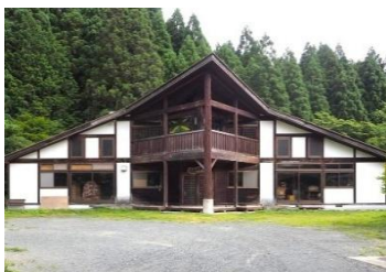
写真 建物外観
