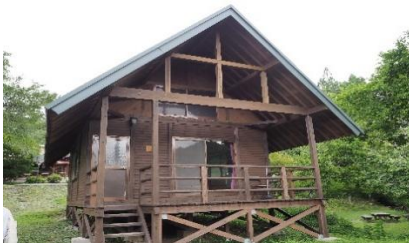
写真 建物外観
