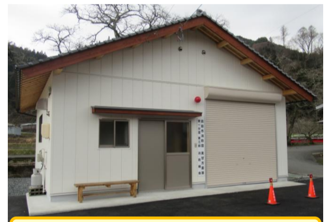
完成した第一分団第三部消防機庫
