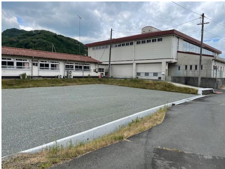
⑤プール跡北側から南西方面 (令和7年8月6日撮影)
