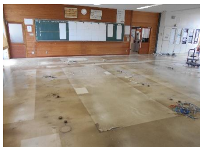
改修前の職員室の床
