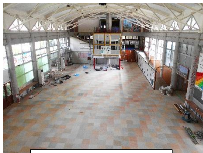
改修前の多目的ホール
