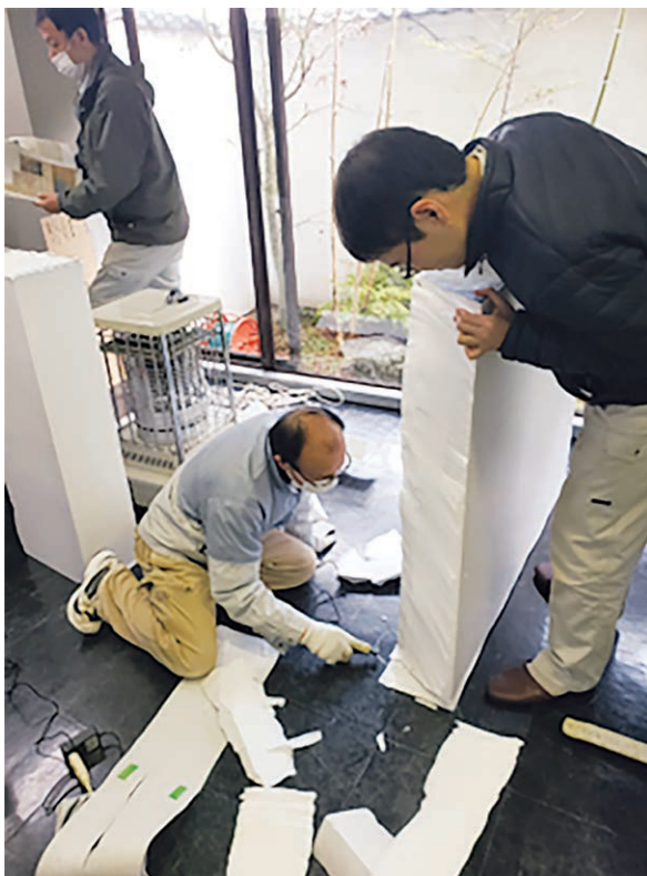
エントランス展示・体験ブース構築作業
