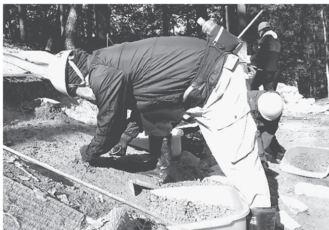
トレンチ2の掘り下げ作業
