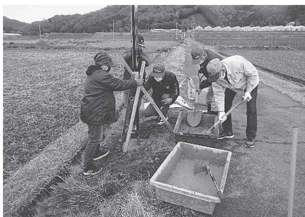
案内看板設置作業
