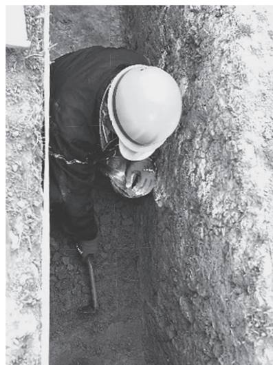
トレンチ4の掘り下げ作業
