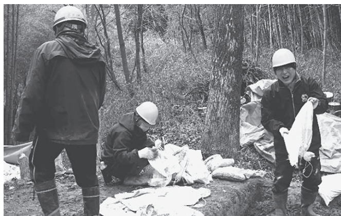
トレンチ3の埋め戻し作業
