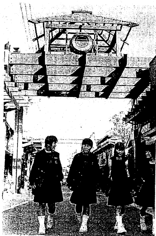
特産のヒノキでアーチを造り活性化をはかる商店街(岡山・勝山町)
