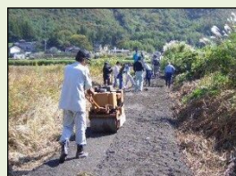
未舗装農道の舗装
