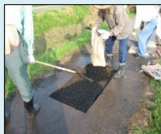
農道の部分補修
