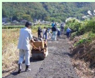
未舗装農道の舗装
