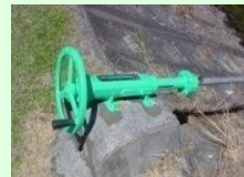
ゲート、バルブの更新
