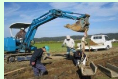
コンクリート水路の更新
