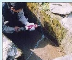
ひび割れの補修
