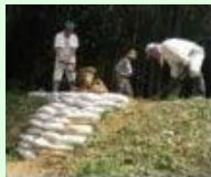
漏水箇所の補修
