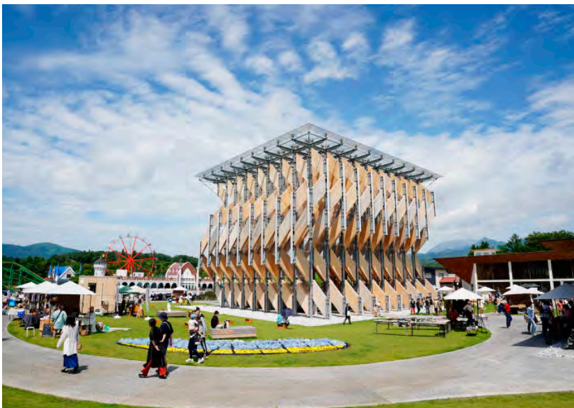
蒜山高原の新しいランドマークになっているCLTパビリオン「風の葉」
