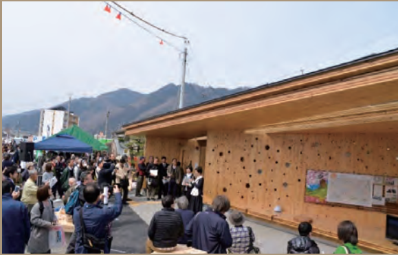
久世駅CLTモデル建築物「木テラス」竣工=平成29年（2017年）3月
