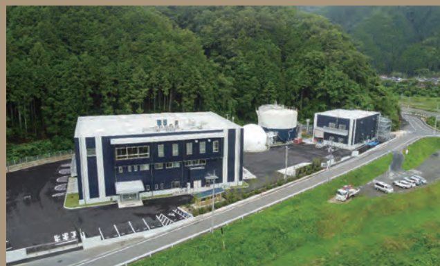
真庭くらしの循環センター「まにくる〜ん」本格稼働 =令和7年(2025年)1月
