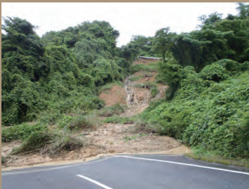
西日本豪雨により土砂崩れなどが発生 =平成30年（2018年）7月
