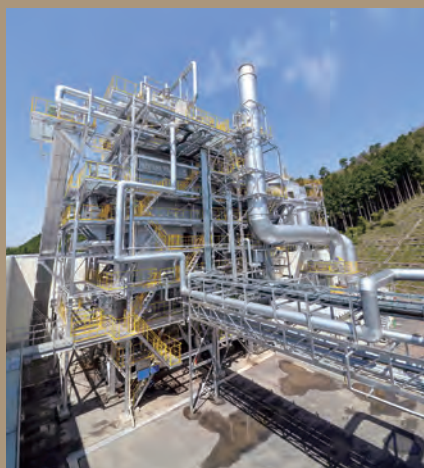
真庭バイオマス発電所が運転開始 =平成27年(2015年)4月
