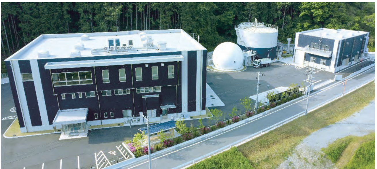
真庭市くらしの循環センター「まにくるーん」の全景。左手が生ごみ等資源化施設、白い球体がガス貯留槽、その右隣がメタン発酵槽、右端がバイオ液肥濃縮施設
