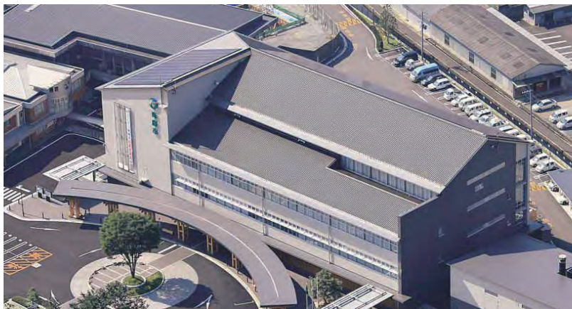
市役所庁舎全景
