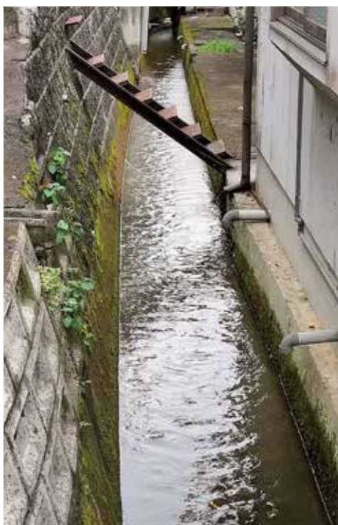
農業用水路は街の排水路としても重要 落合垂水
