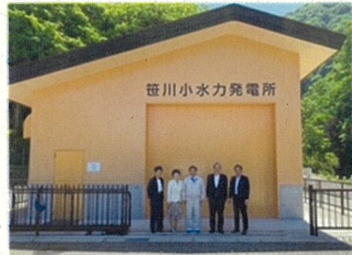
発電所建屋にて
