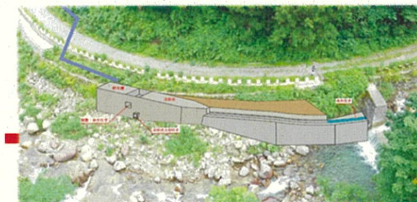
取水部工事完成
