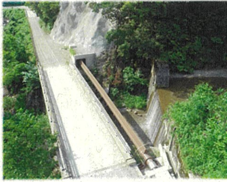
小鷲谷水管橋
