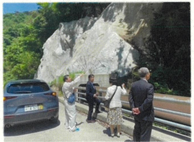
小鷲谷水管橋
