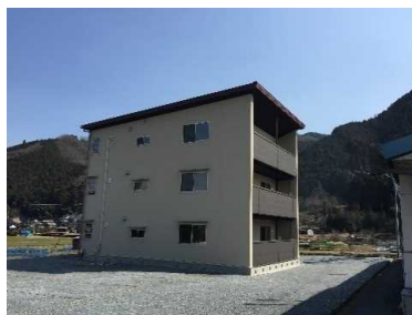
⑬CLT春日住宅(勝山：単独住宅)
