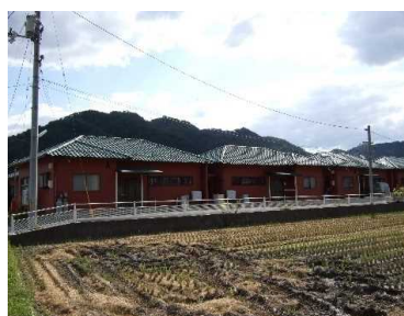
④水田住宅(北房：公営住宅)
