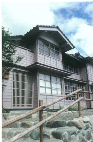
大正時代に建てられた旧写真館を平成13年に「木にこだわった街づくり事業」で改修した。
