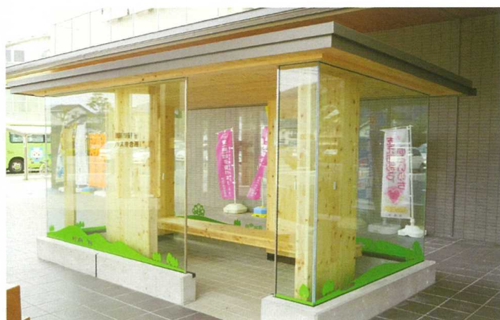
CLTを使用したバス待合所（真庭市本庁舎前）
