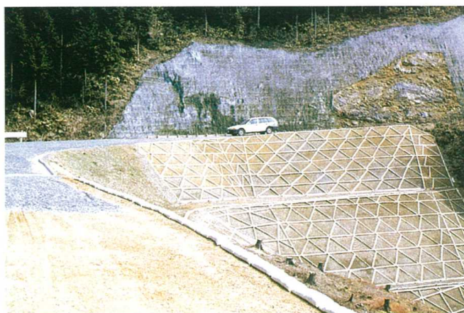
間伐材を利用したトラスウッド工法
