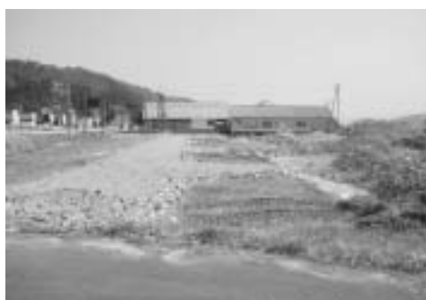
造成の進む道の駅風の家駐車場
