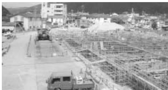
久世庁舎敷地内に建設の進む新本庁舎
