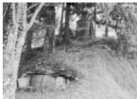
水道未普及地区の水道施設
