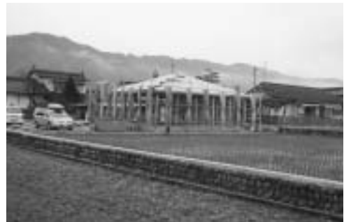
公共事業により建設中のコミュニティハウス(中地区)
