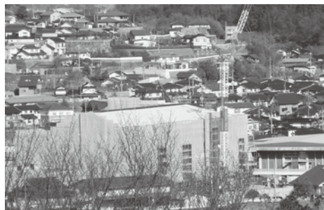
建設の進む真庭市役所本庁舎
