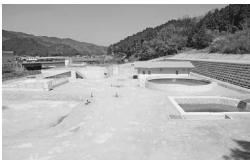
建設が進む落合浄化センター
