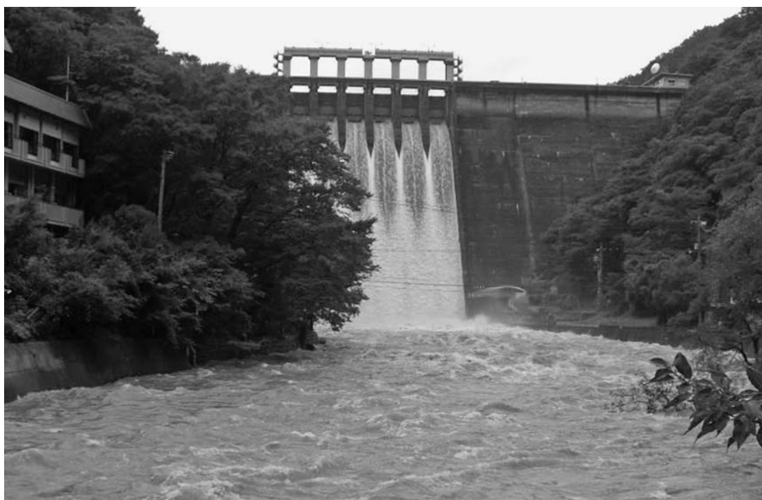
台風12号による過去最大の放流（湯原ダム）
