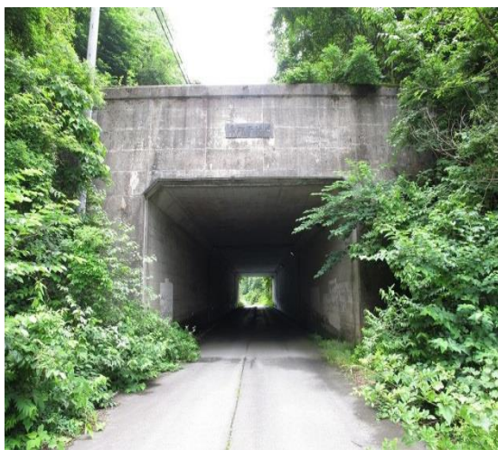
真加子隧道 起点側坑口
