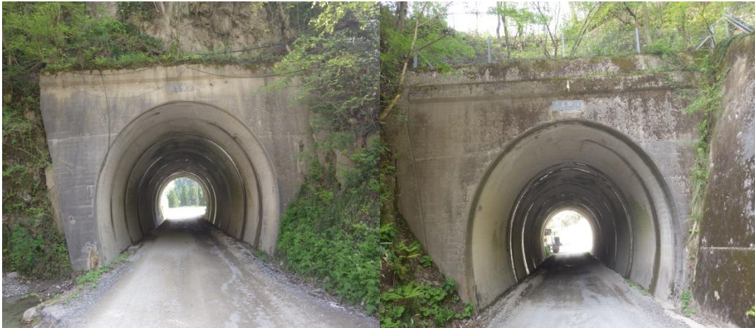
馬背隧道 起点側坑口
