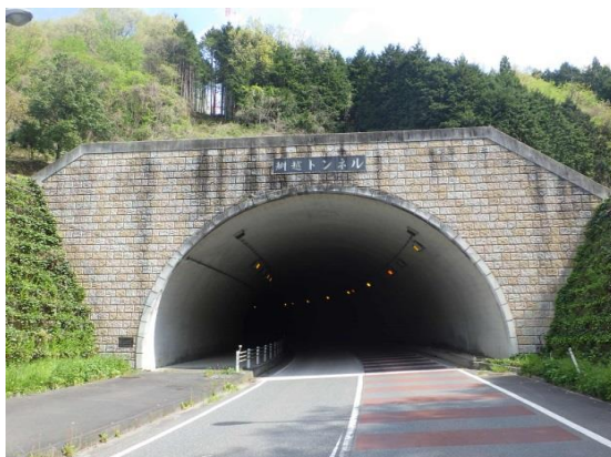
鮎越トンネル 起点側坑口
