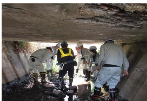
橋梁点検実習状況
