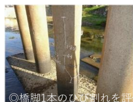
◎橋脚1本のひび割れを評価
