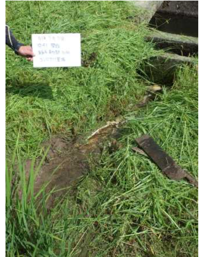
排水口の せき止め板解除
