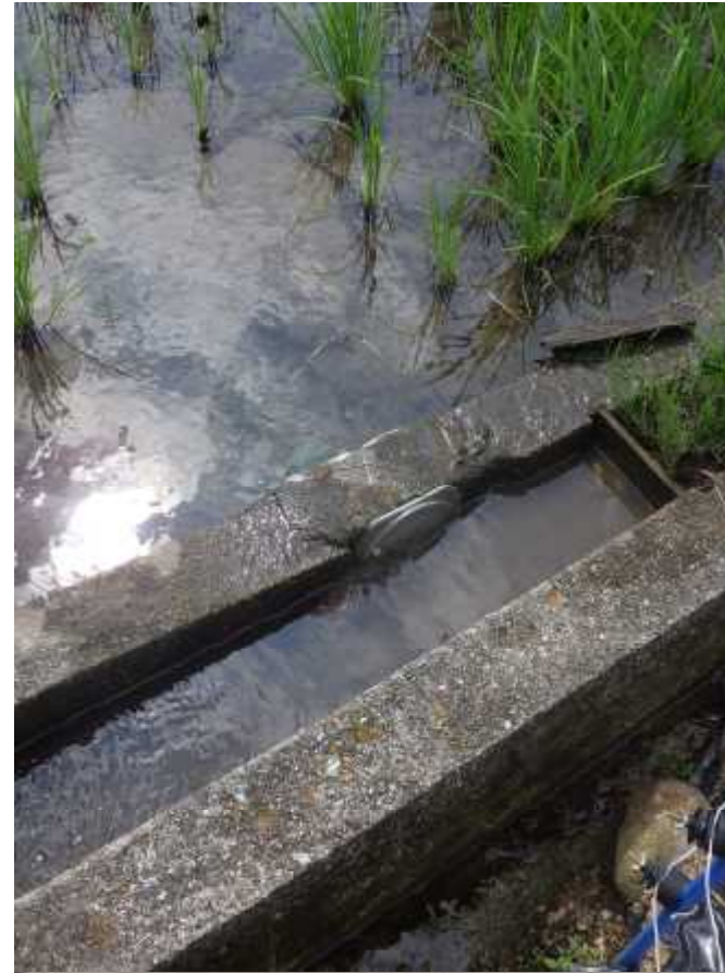
取水口のせき止め
