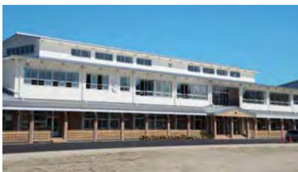
▶新築された蒜山中学校
