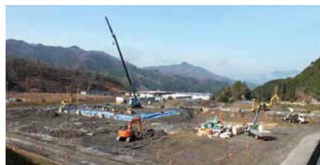
基礎工事が進む真庭バイオマス発電所
