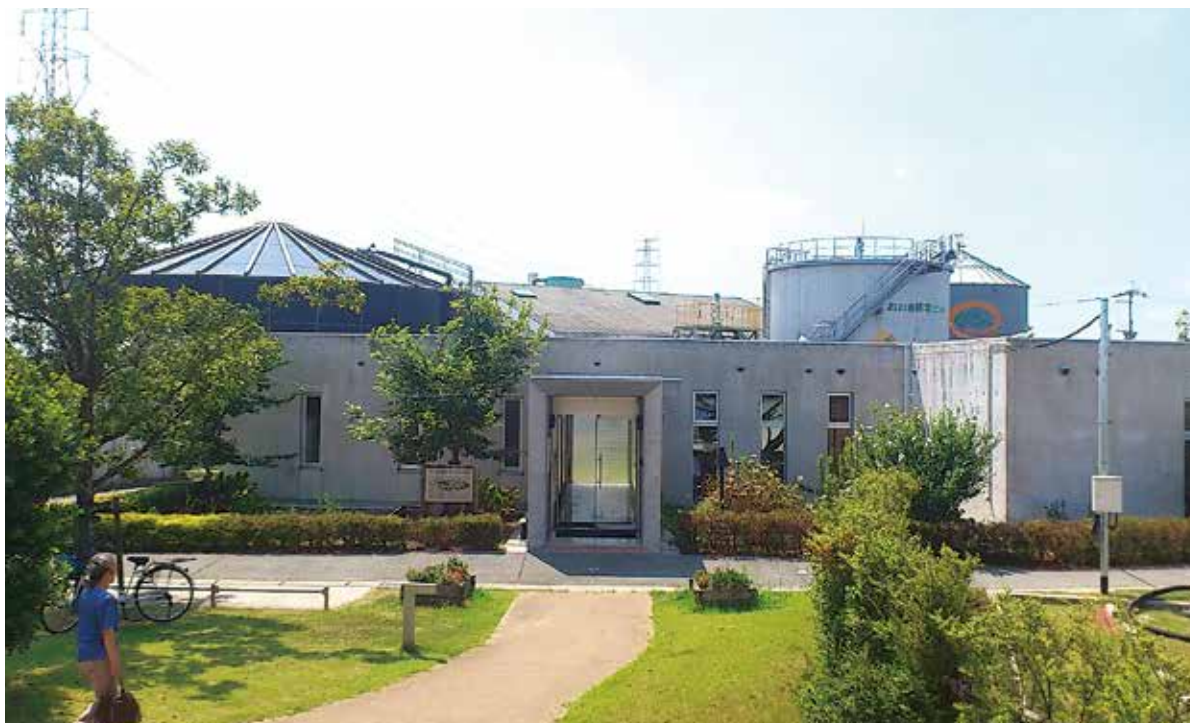
生ごみからメタンガスと液肥を製造している「おoki循環センターくるるん」(福岡県大木町)
