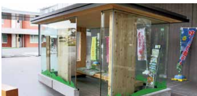
CLT (直交集成板)を使った市役所前のバス待合所
