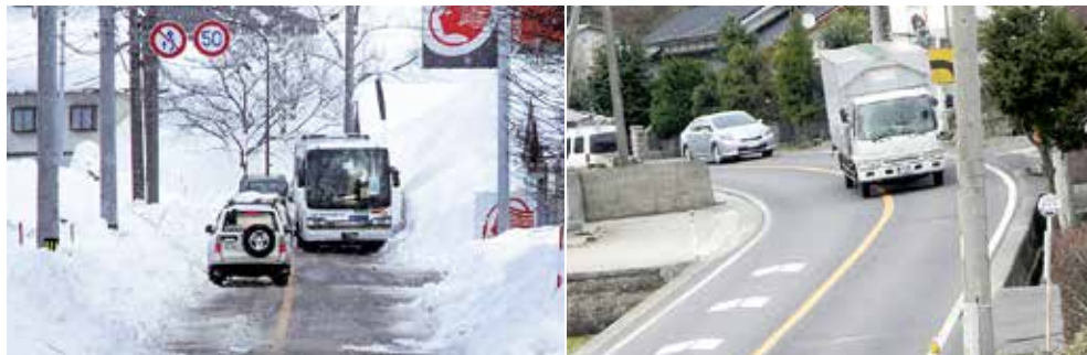
現在の国道 313 号 (どちらも蒜山下長田地内)
