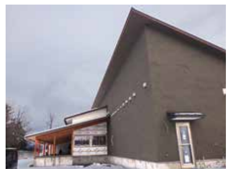
建設中の真庭市学習交流センター 蒜山上長田
