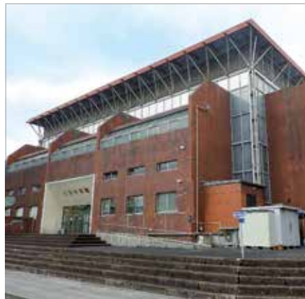
解体が予定されている久世体育館
