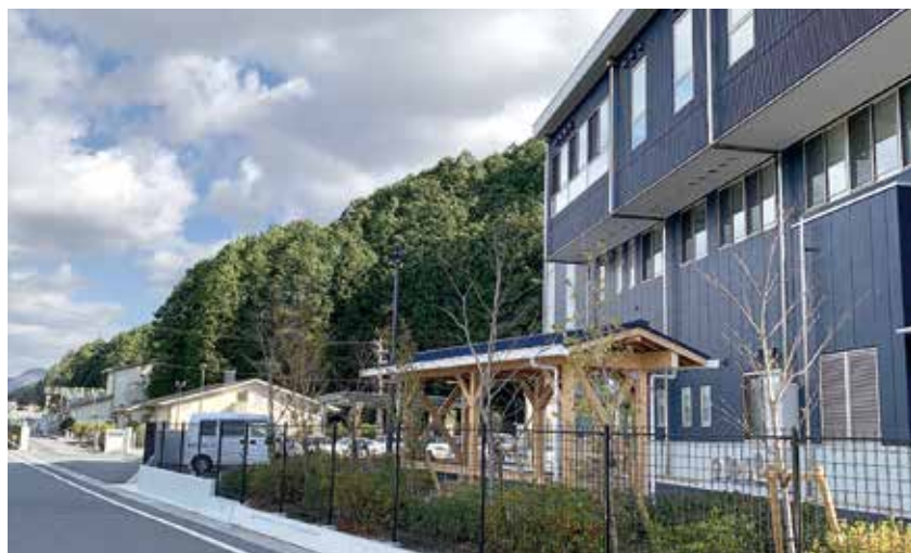
落合浄化センターの隣に完成した真庭市くらしの循環センター 赤野
