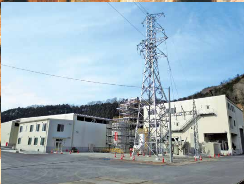
▲4月の運転開始に向け工事が進む真庭バイオマス発電所（1月5日撮影）
