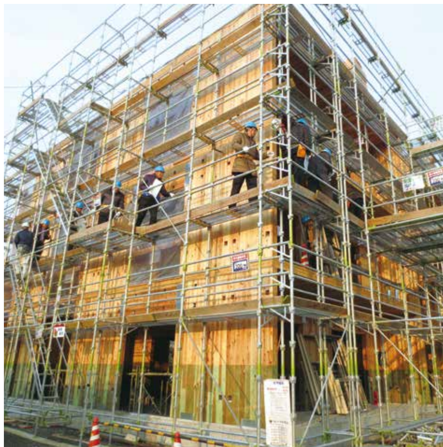
真庭市議会議員が参加した CLT 住宅構造見学会（真庭木材事業協同組合）
