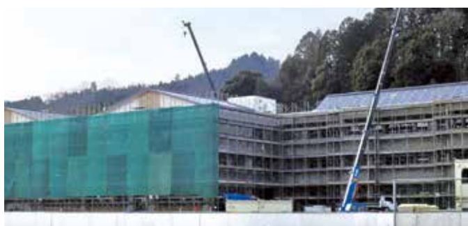
新築工事中の落合中学校校舎
