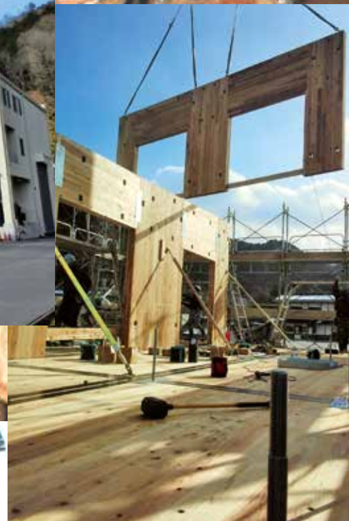
▲CLTを使用した住宅の建築工事の様子 （春日住宅）
