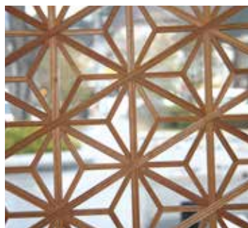
市役所玄関の組子(麻の葉組)
