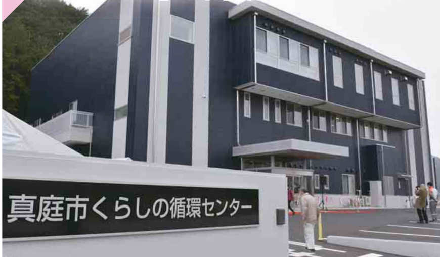
生ごみ等資源化施設
