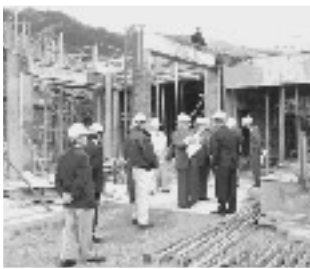
温水プール工事現場
