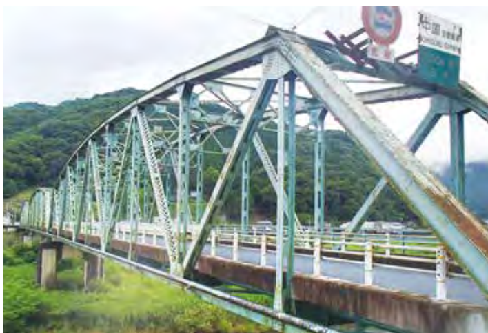
修繕予定の落合橋
