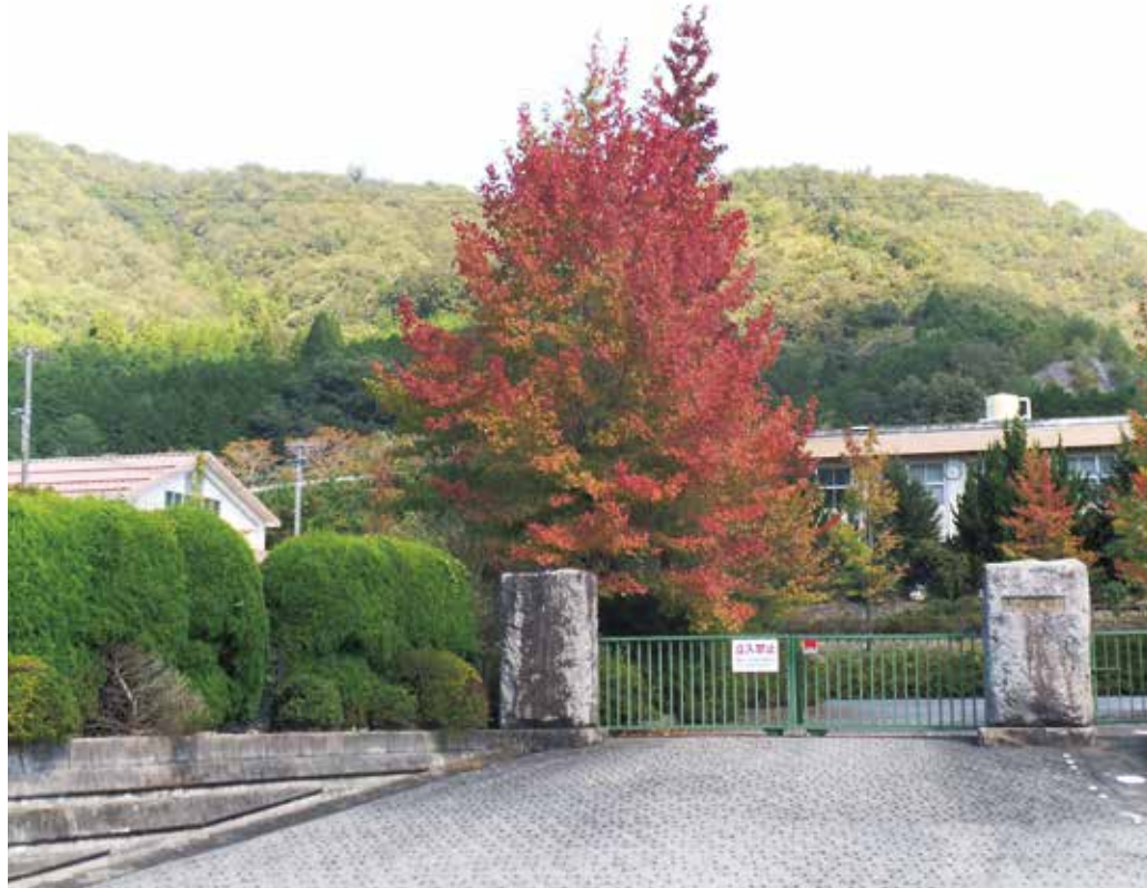
北房統合小学校(仮称)等が建設される旧至道高校跡地
