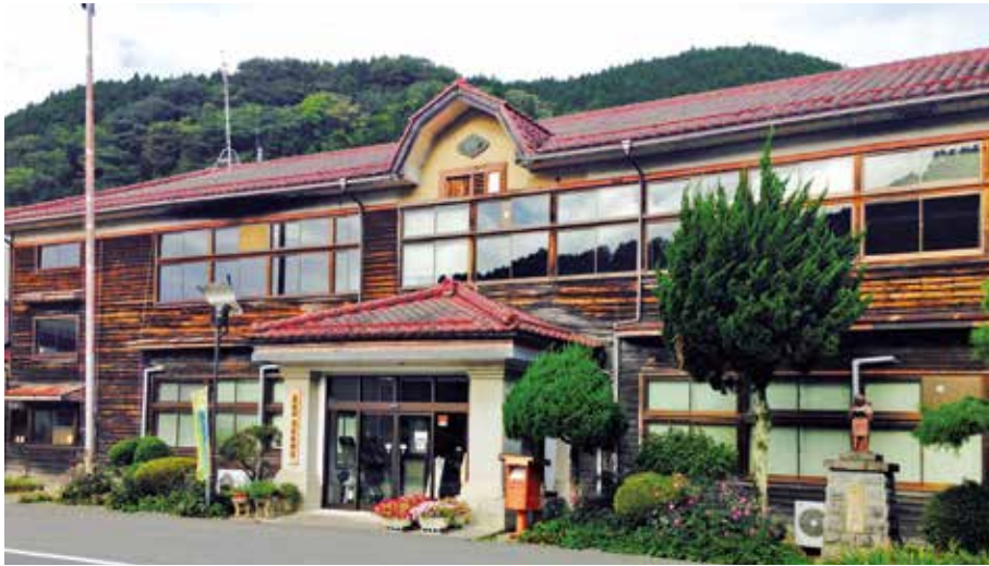
老朽化(築65年)した湯原振興局庁舎
