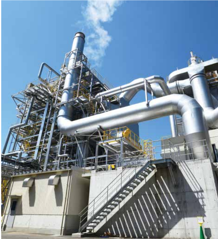
真庭バイオマス発電所
