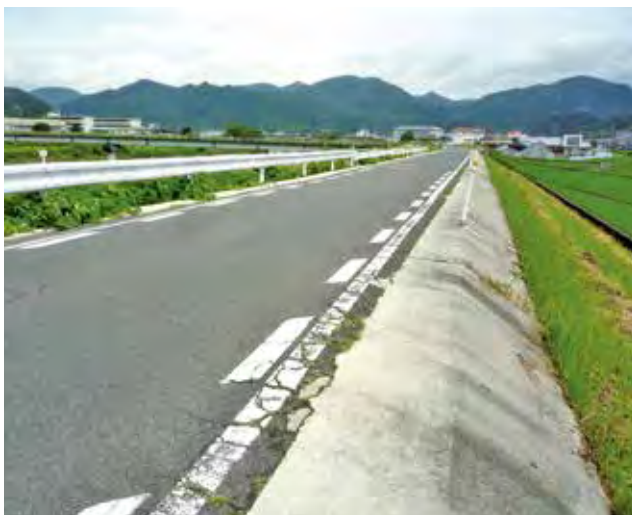
路肩保護コンクリート施工の状況（県道西原久世線・久世地内）
