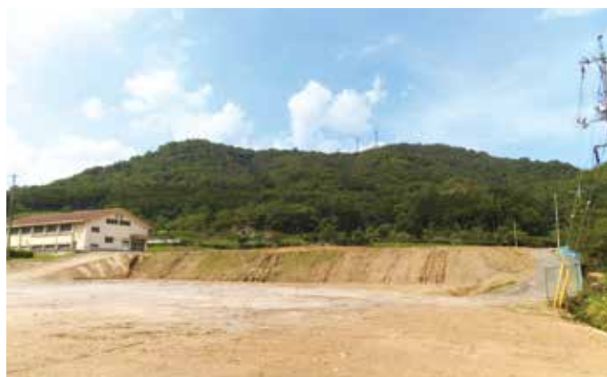
北房統合小学校（仮称）等建設予定地（旧至道高校跡地）
