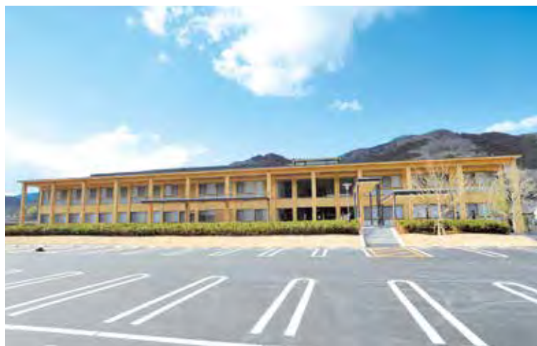
真庭産材を利用した落合総合センター
