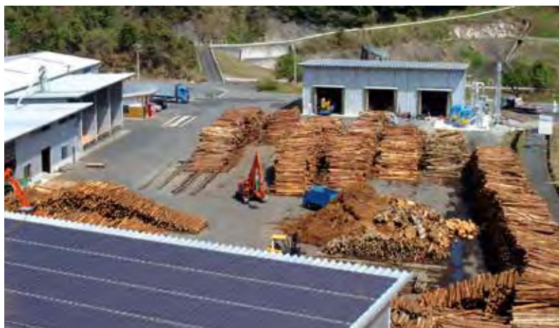
バイオマス集積基地第1工場（目木）
