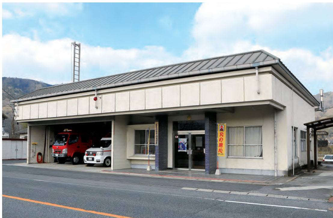
築後 40 年以上が経過し、老朽化が進む北房分署
