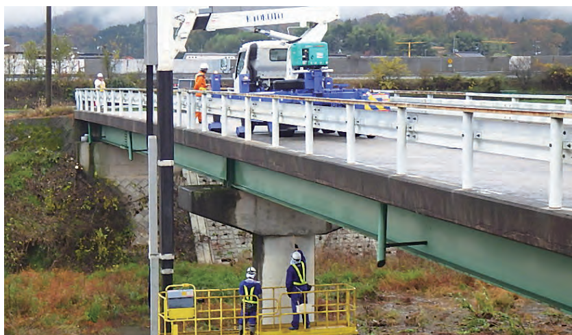
橋梁点検車による点検（上水田地内）
