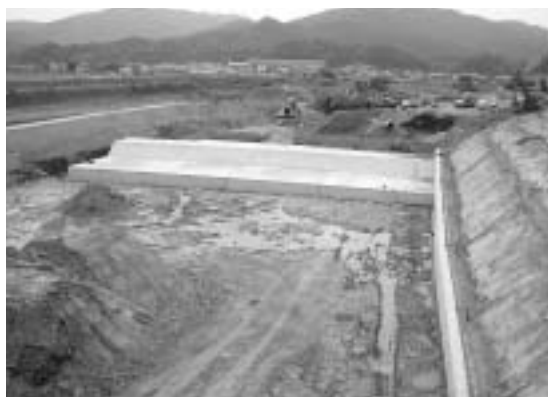
備中川河川改修（野畑床固工事）
