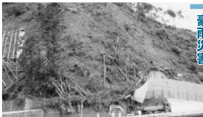
災害現場(真庭市檜西)
