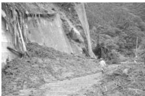
見尾地内崩落現場
