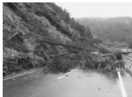
県道鏡野久世線の崩落(7月18日)
