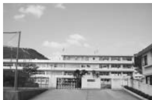
勝山小学校校舎
