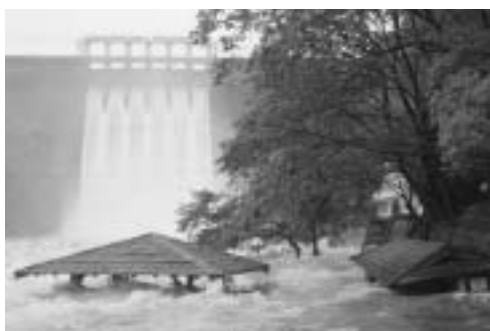
湯原ダム放流(7月19日)
