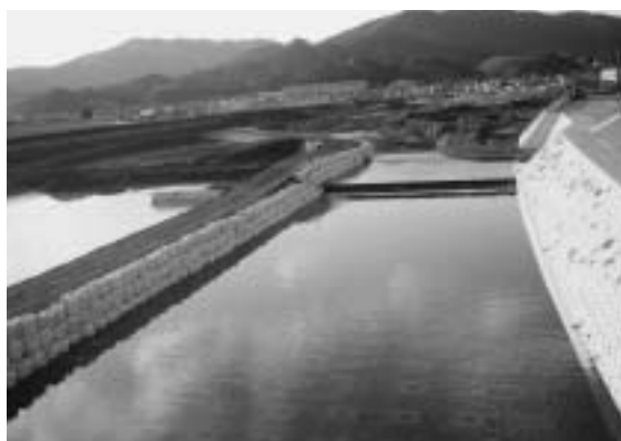
野畑床固工事(19年1月)
