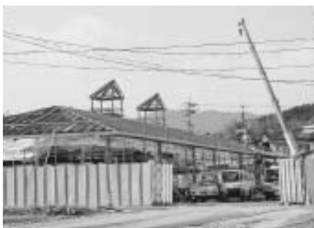
建設中の幼児教育センター（H19年1月）
