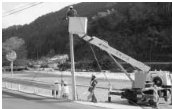
月田本地内の工事
