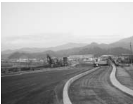
垂水バイパス工事(19年1月)
