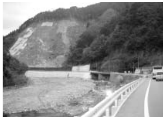
見尾地区工事(19年1月)
