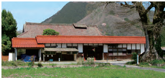
今年度中に撤去される目木構
