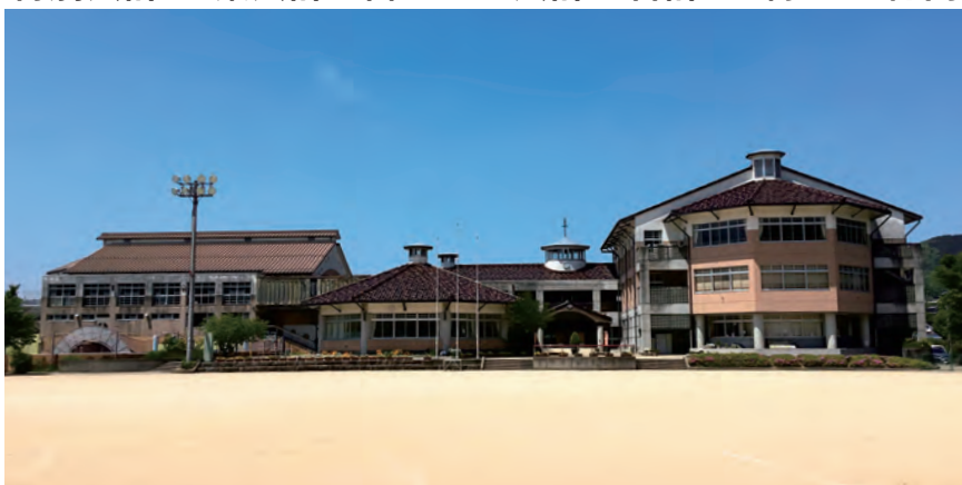
写真は米来小学校 市内18の小学校(2校設置済み)にエアコンが設置されます
