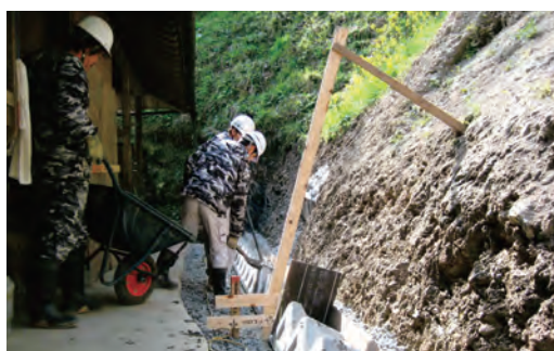
動き出した民家の災害復旧工事 山久世地区
