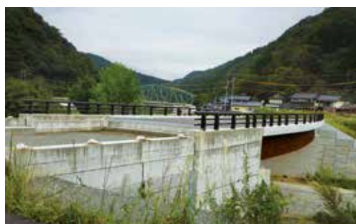
建設中の橋梁 旦土地内
