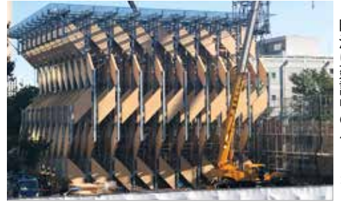
晴海に建設中のパビリオン
