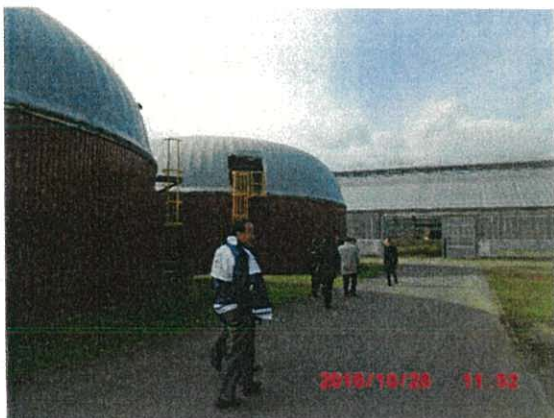
発酵槽。上部の丸型ドームでメタンガスを回収する。
