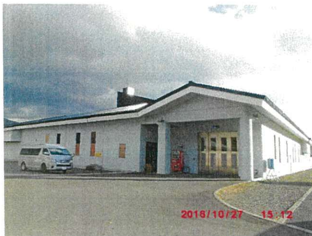
生ゴミ、糞尿等処理施設棟。入り口からバキュームカーが進入。
