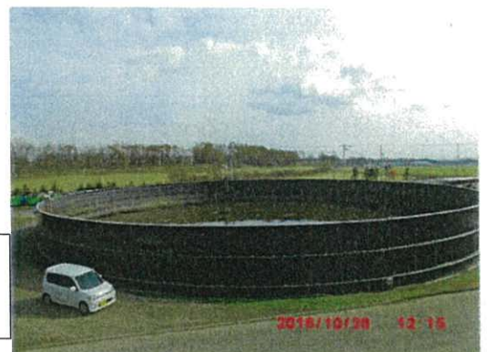
消化液貯留槽。精製された消化液は不純物を取り除き殺菌したものでありほとんど臭わない。
