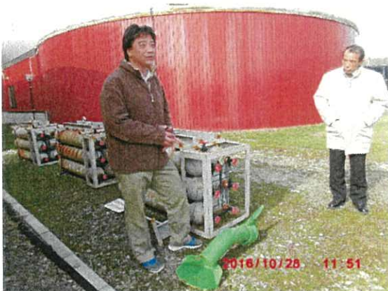
精製装置から配管し、ボンベに充填している。メタンガスは比重が重たく、1本が80kgと扱いにくい。
