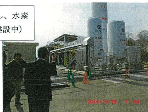
水素ステーション。（水素スタンドで建設中） この施設では、水素を製造、貯蓄、輸送、供給し、燃料電池自動車や燃料電池等へ利用するまでの一貫した水素サプライチェーンの実証を行う予定。
