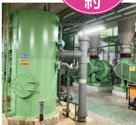
真庭市し尿処理施設旭水苑 処理棟内
