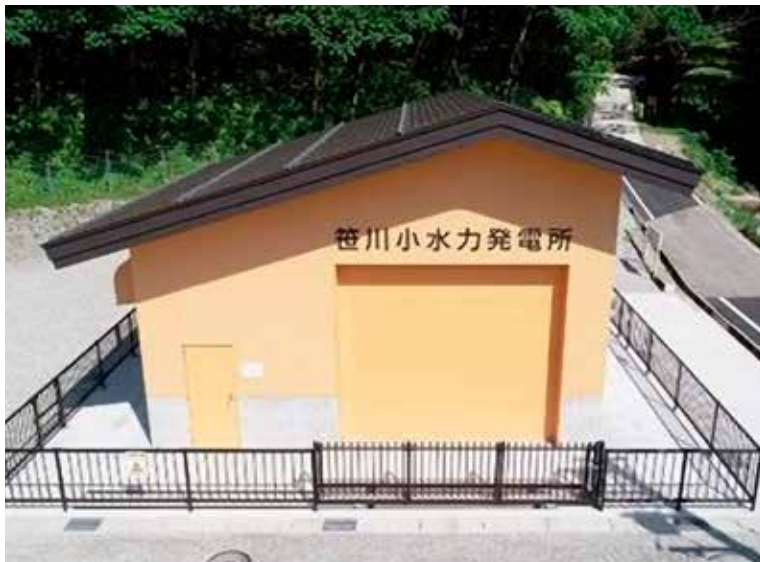
笹川小水力発電所 富山県朝日町
