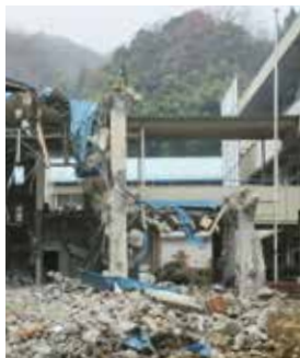
旧津田小解体工事 巨土
