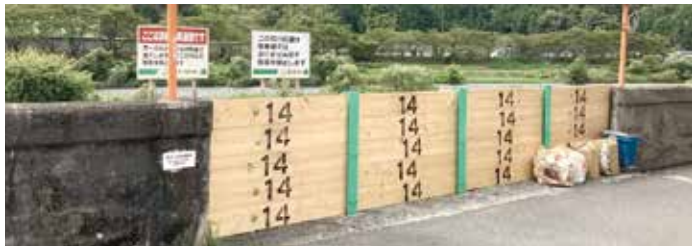
台風10号に登場した久世街裏堤防の陸閘(りっこう) すごいTo
