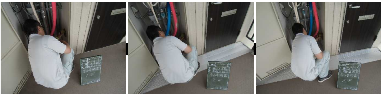
写真一 9 含水率調査状況（平成28年7月22日）
