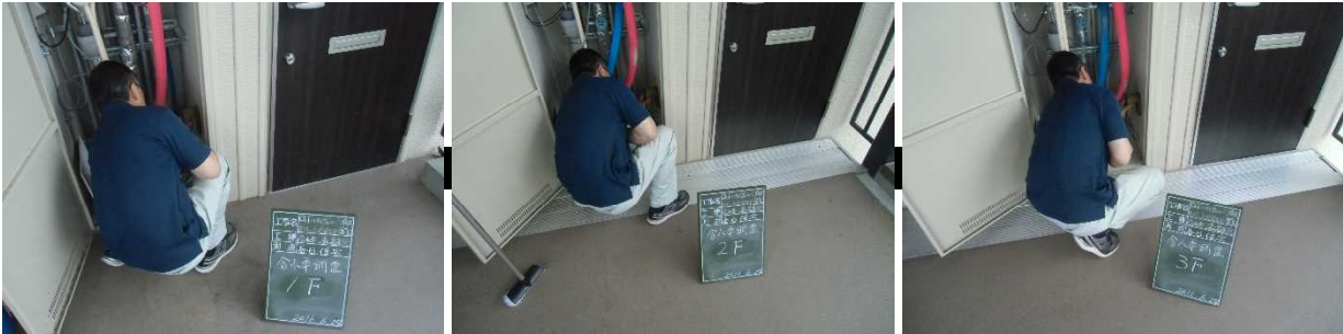
写真一 7 含水率調査状況（平成28年6月24日）
