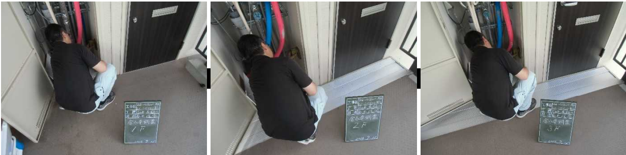
写真一 8 含水率調査状況（平成28年7月11日）
