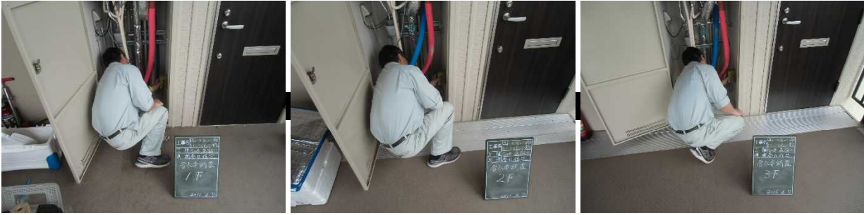
写真一 6 含水率調査状況（平成28年6月7日）
