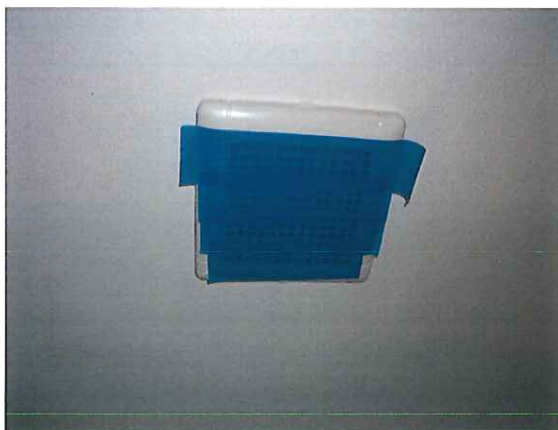
写真：O4_浴室 換気扇目張り状況
