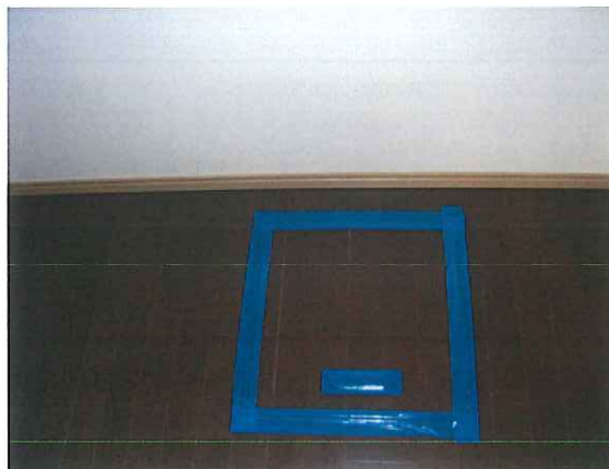
写真：04_床下点検口目張り状況
