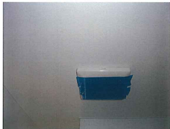
写真：03_便所 換気扇目張り状況
