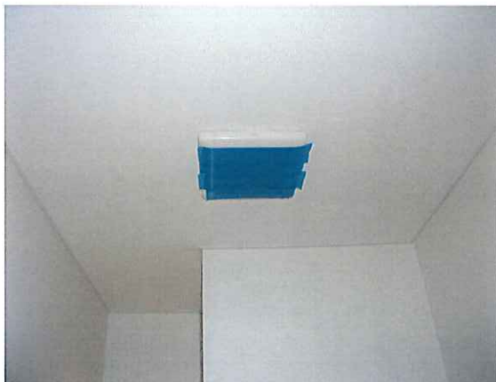
写真：O3_便所 換気扇目張り状況
