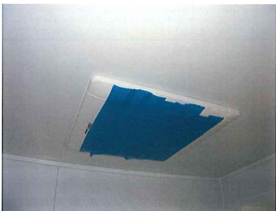
写真：04_浴室 換気扇目張り状況
