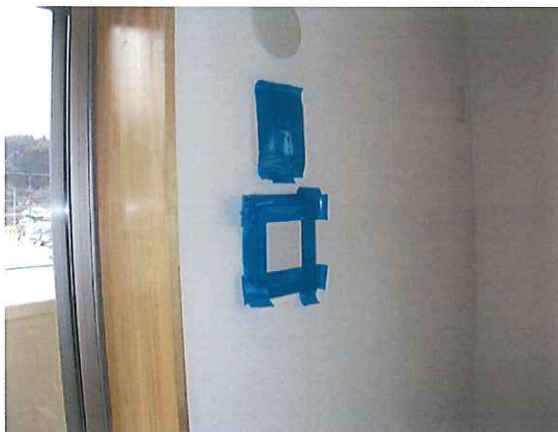
写真：O2_リビング 換気レジスター目張り状況
