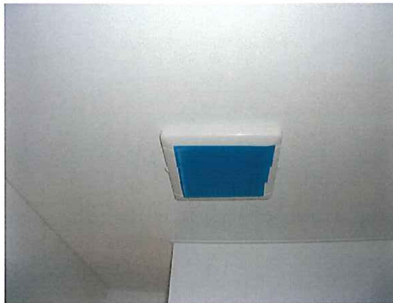
写真：03_便所 換気扇目張り状況
