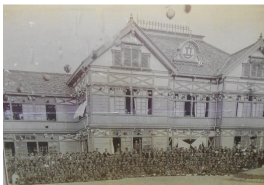
明治40年7月20日校舎完成式典の様子
