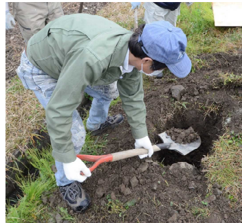
手分けをして看板設置作業をする様子
