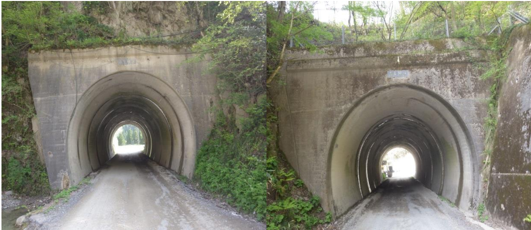
馬背隧道 起点側坑口
