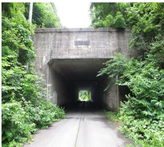
真加子隧道 起点側坑口
