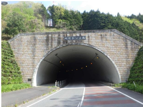
鮎越トンネル 起点側坑口
